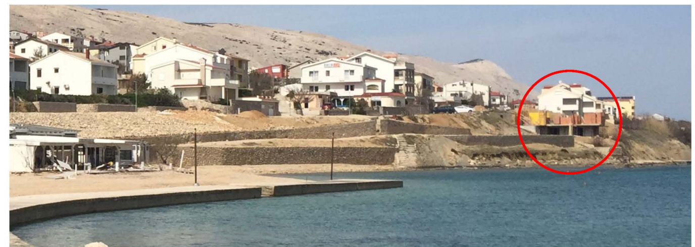
Sl.2. nedovršena trasa pješačke priobalne staze „lungo mare“ prekinuta neplanskom individualno izgradnjom
