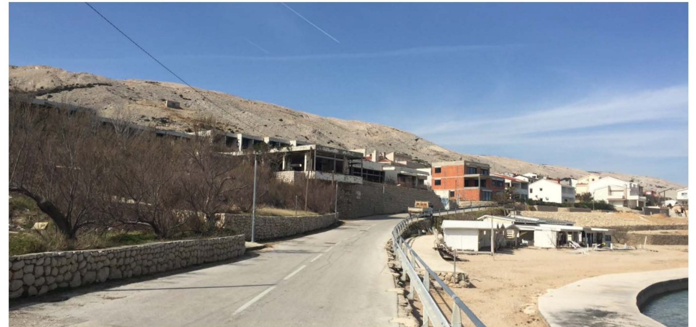
Sl.9. ulica Prosika prema zapadu – pogled na hotelski kompleks Bellevue (restoran), stambeno naselje Vodice i zapadno krilo gradske plaže (početak trase „lungo mare“)
