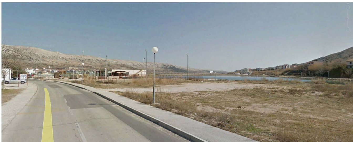
Sl. 4. južna obala unutar zone obuhvata – pogled preko neuređene površine (parking) i napuštenog sportskog centra prema kanalu
