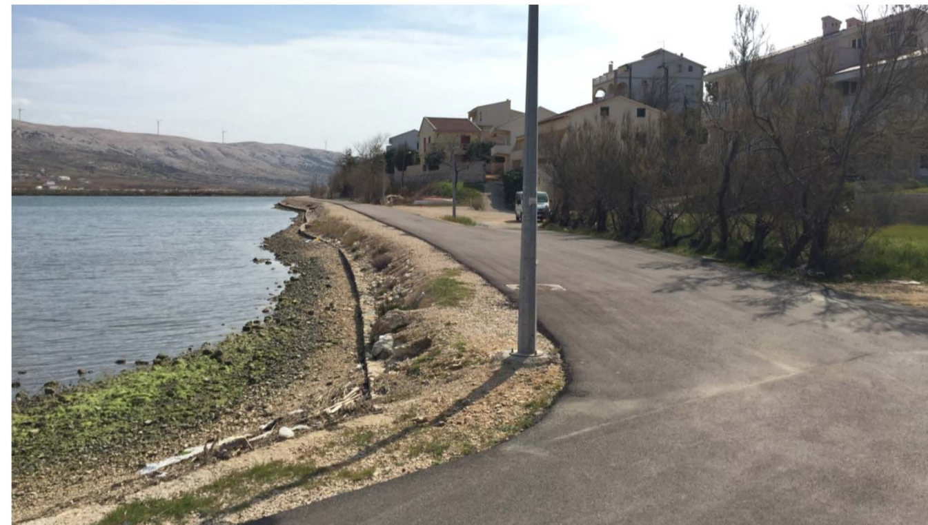
Sl.7. ulica Leopolda Dorkića – pogled prema jugoistoku (kanal)
